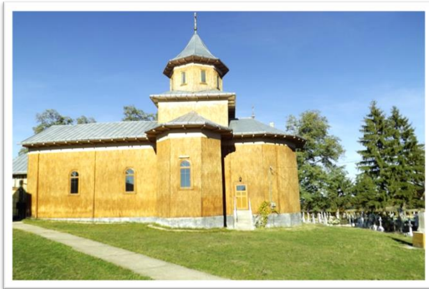
Foto 3: Biserica de lemn cu hramul „Sf. Voievozi” din Homița, al doilea sat component al comunei Cristești : singura biserică de lemn din zonă, construită în 1840, construită pe temelie de piatră, are formă de cruce cu o singură turlă pe naos și două abside decroșate în exterior.
